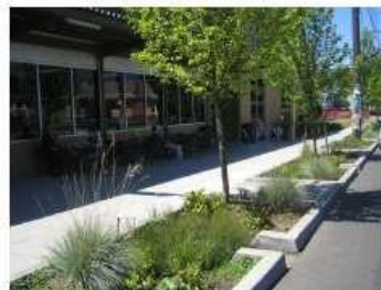
Exemplo de aplicação de canteiro pluvial para armazenamento e absorção de água
